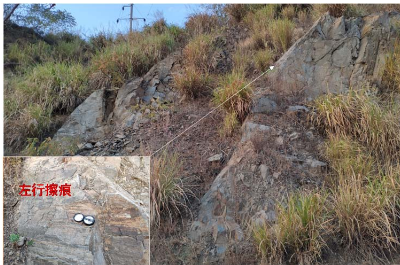
照片 3.3-6 铁铺湾蕲州断裂构造特征(断层远视镜向 0^\circ ，左行擦痕镜向 50^\circ )
