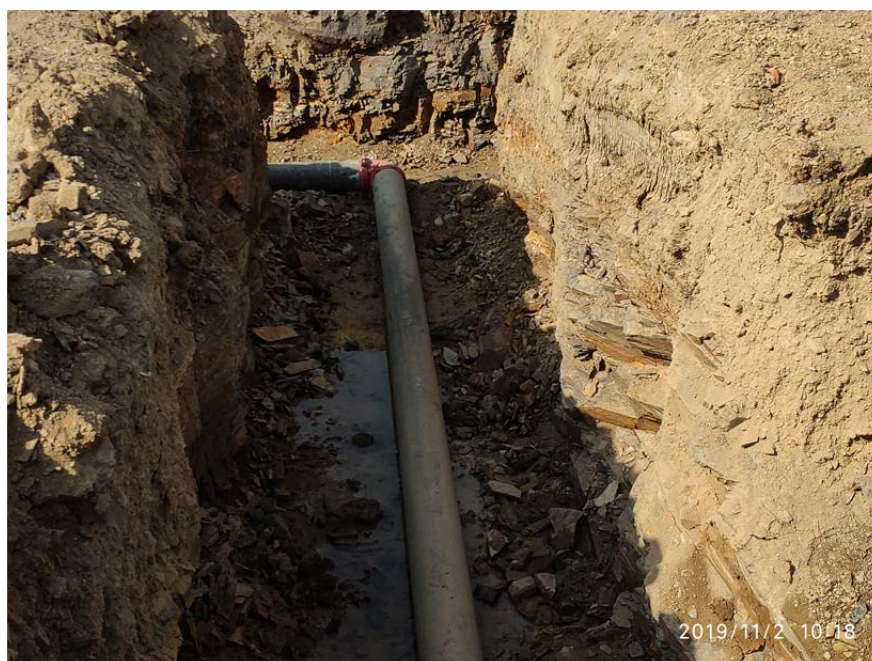
图 6.5-1 章山铁铺脑附近施工场地开挖的弱风化基岩
