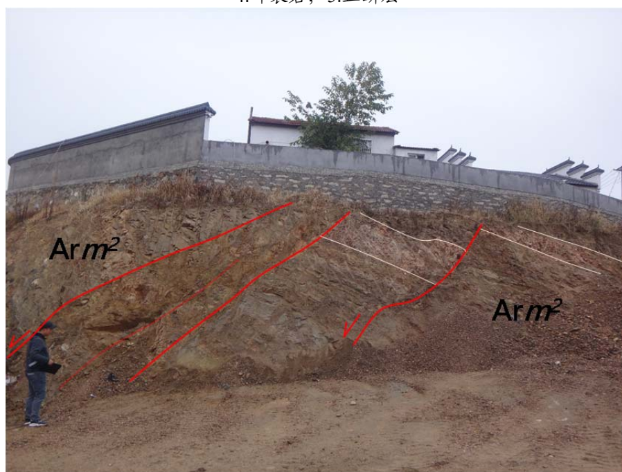
照片 3.3-15 石头湾巴河断裂构造特征(镜向 SW)
