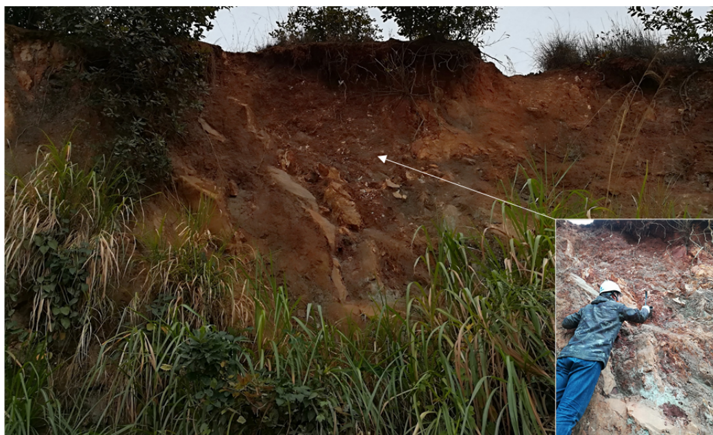
照片 3.3-11 铁铺祠堂蕲州断层构造特征 (断层剖面镜向 350°，断层泥取样镜向 355°)
